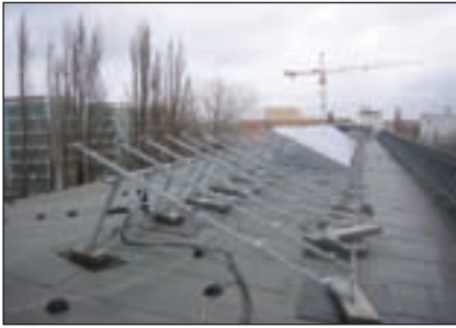
Modulverlust durch Windsog auf einem exponiertem Walmdach
