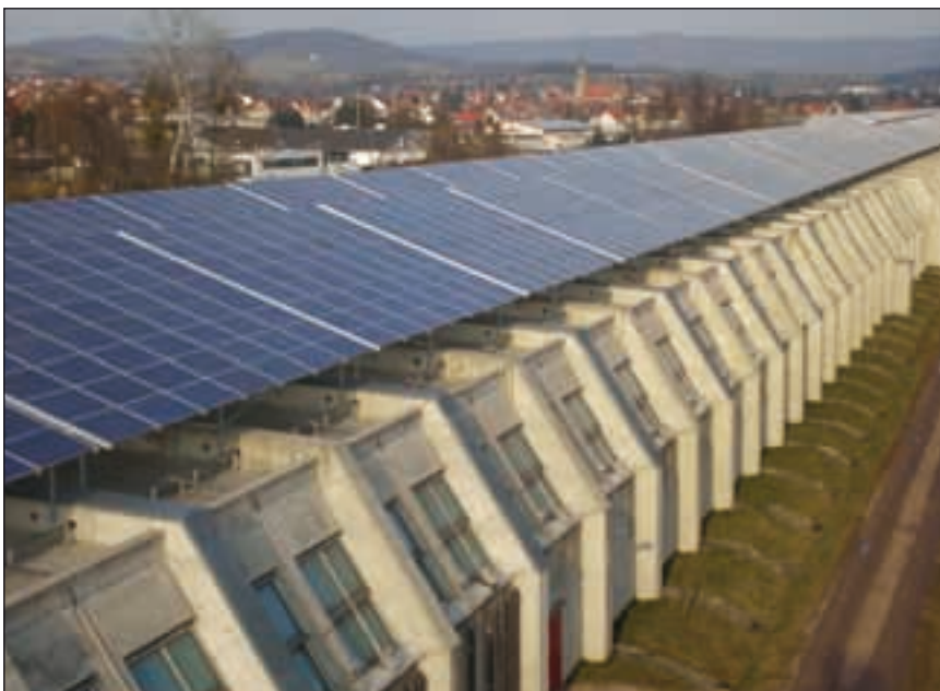
Ein Autobahntunnel, der Strom liefert: Zwischen Hösbach und Aschaffenburg entsteht ein riesiges Solarkraftwerk
