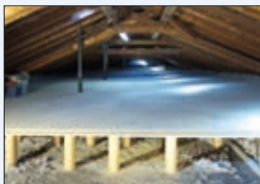
Bild 4: Dämmhülsenkonstruktion
