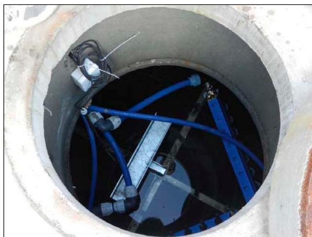
Bild 2: Das innere des SolarEis Speichers
