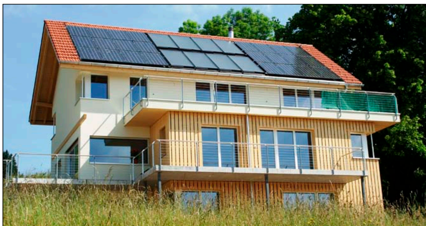
Bild 3: Wohnhaus in Adetswil/Schweiz, ausgestattet mit 8 Hybridkollektoren (Solaera) und PV
