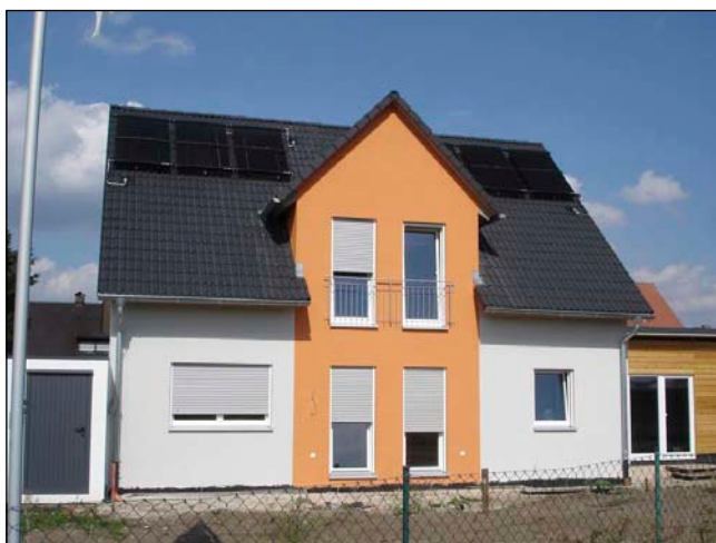
Bild 1: EFH bei Nürnberg, ausgerüstet mit dem SolarEis-System von Isocal/Viessmann
