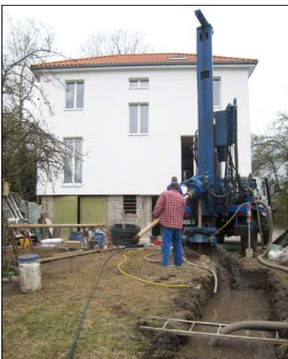
Bild 2: Bohrarbeiten für die Erdwärmesonden
