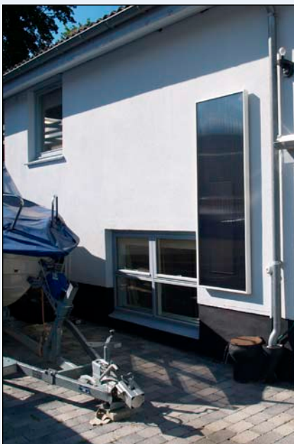
Bild 3: Wandmontage des SolarVenti
