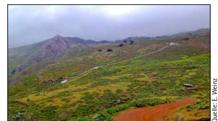
Bild 2: Blick von den Windrädern auf die oberirdische Pipeline und die Pumpen
