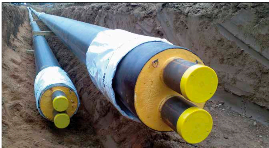
Bild 2: Leitungsverlegung für das Wärmenetz
