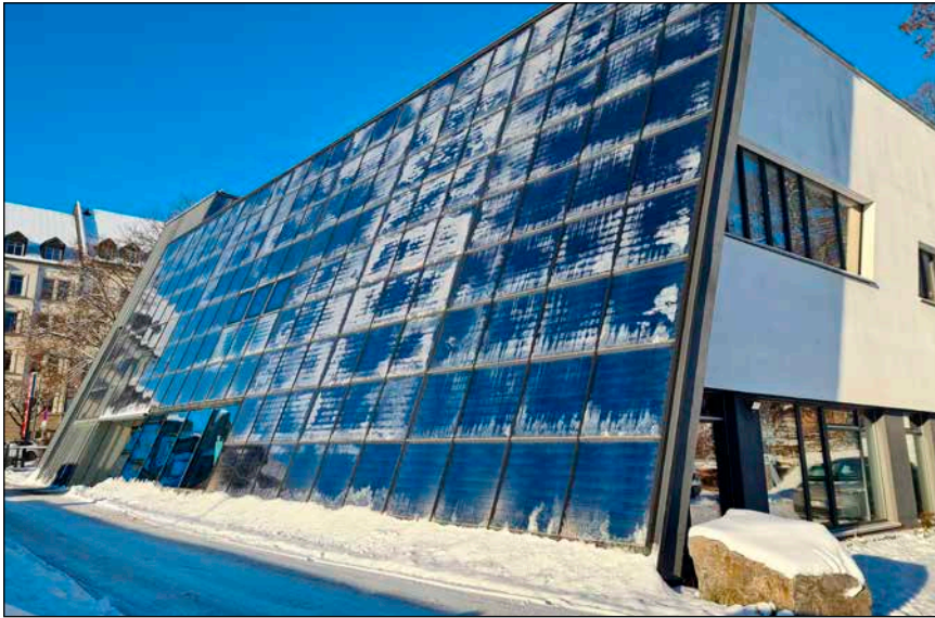
Bild 1: Diese Solarfassade mit 70° Neigung ermöglicht solare Gewinne vor allem in den Wintermonaten.
