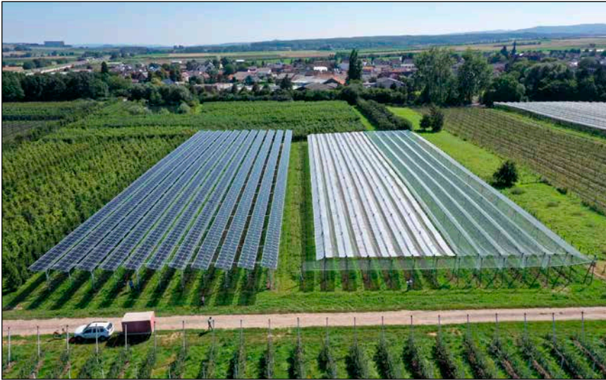
Bild 1: Flächensynergie: Spalierobst-Plantage unter einer Agri-PV-Anlage. Die Module schützen empfindliche Früchte wie Kirschen oder Johannisbeeren vor Hagelschlag u. ä., und profitieren zugleich in der Sommerhitze von der Verdunstungs-Kühle der Pflanzen
