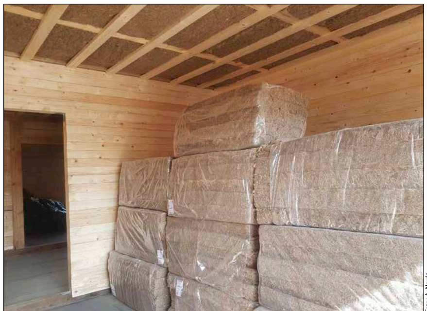
Bild 4: Grasfasermatten von Gramitherm zur Innendämmung eines Kindergarten-Neubau
