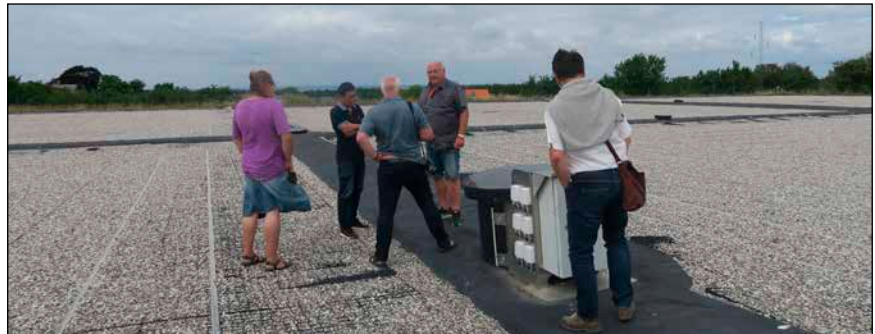
Bild 3: Leo Holm (4. Person v.r.) erläutert die schwimmende Dämmung vom Erdbeckenwärmespeicher
