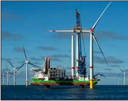
Errichtung des Windparks Kaskasi in der Nähe von Helgoland: Die Offshore-Windenergie wird von den Energiekonzernen beherrscht.
