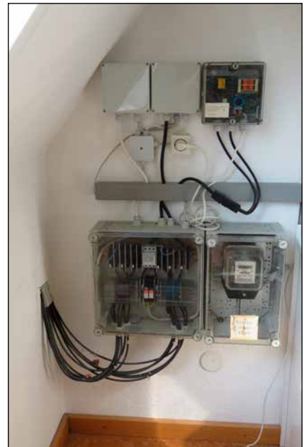
Bild 2: Generatoranschlusskasten, drei Modulwechselrichter und der Stromzähler im ehemaligen Büroraum
