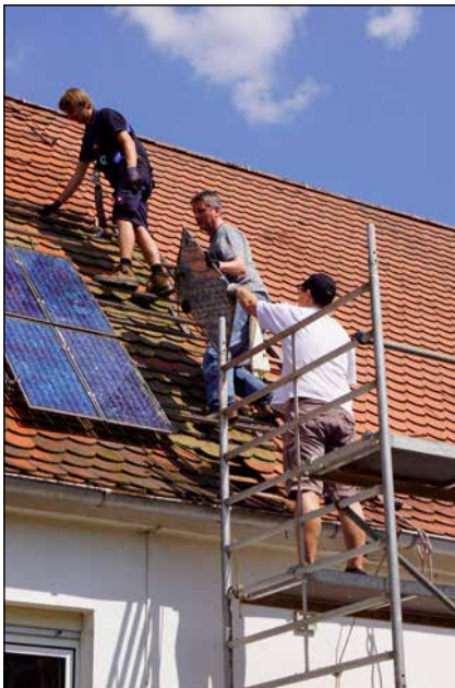
Bild 1: Jan Hufnagel, Thomas Seltmann und Leonhard Hüttinger bei der Demontage der Solarmodule
