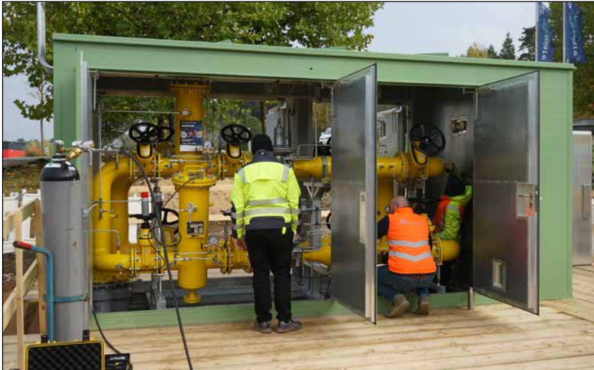
Bild 1: Technische Abnahme einer der neuen Gasdruck- Mess- und Regelstationen.
