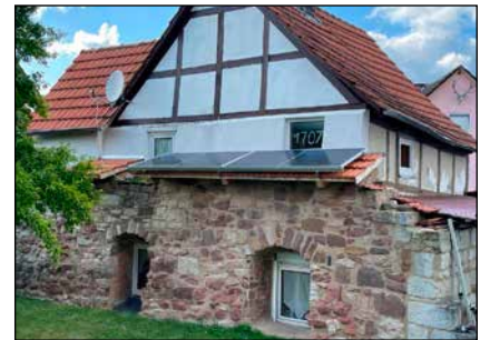
Stationäres Balkonkraftwerk in Lohfelden Crumbach
