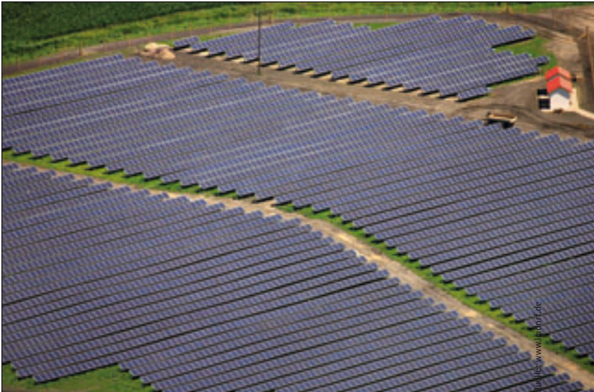
Der Photovoltaikmarkt boomt: Hier das Solarstromkraftwerk Haimhausen (Landkreis Dachau)
