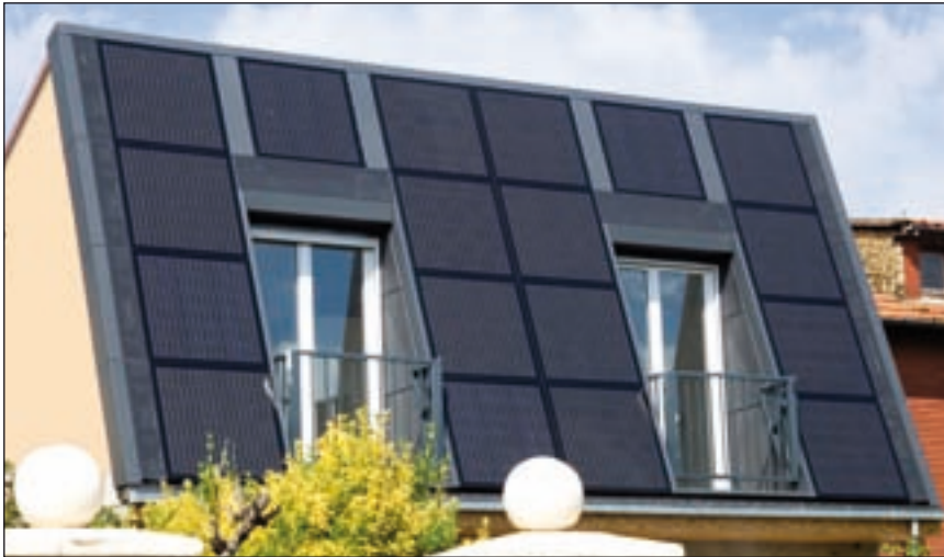
Bild 1: Integration nicht nur in das Gebäude, sondern auch in die Netze ist eines der Ziele der Roadmap
