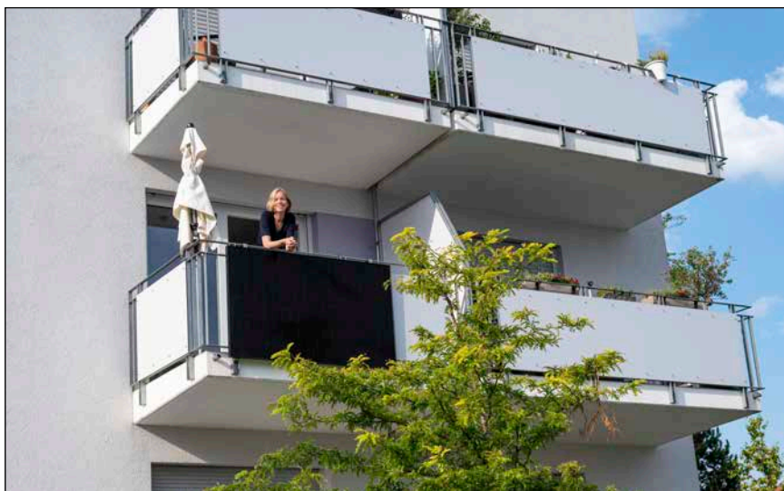
Bild 1: Die senkrechte Montage mit dem Solar-Hook liefert weniger Ertrag, hat aber Vorteile für die Stabilität.
