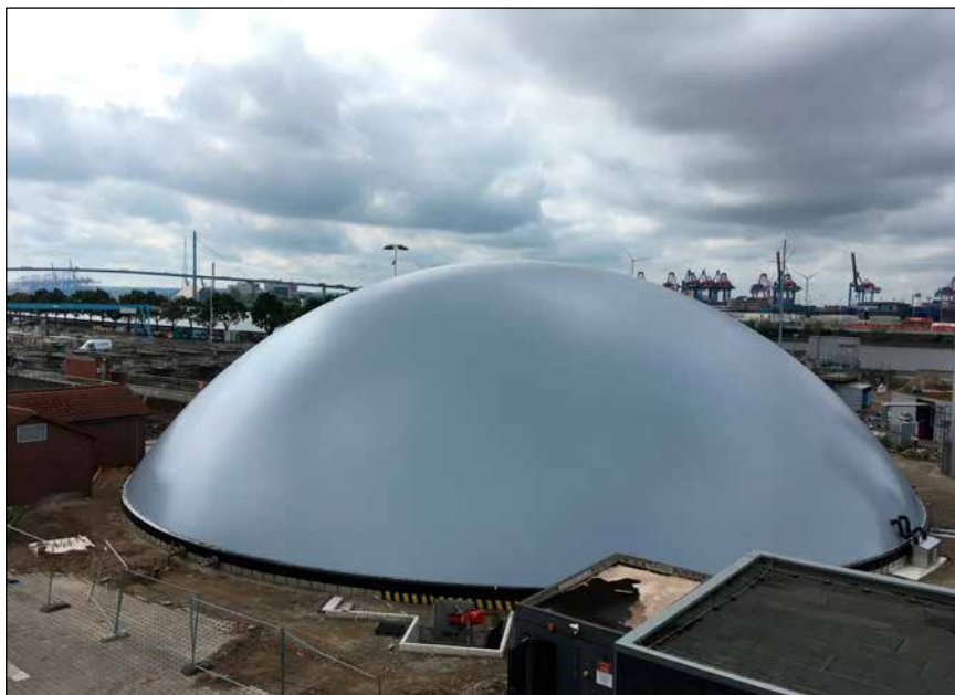
Bild 4: Leider immer noch ein Ausnahmeprojekt: abgedeckter Klärschlamm-Speicher von Hamburg Wasser
