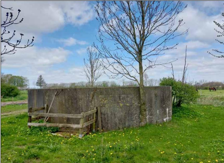
Bild 3: In den ausbetonierten Güllebehältern der Landwirtschaft steckt nicht nur Düngerpotential; abgedeckt können sie auch als Gasquelle genutzt werden.
