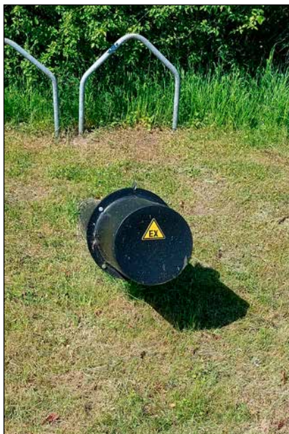
Bild 2: Kontrollschacht für Deponiegase: die (Klima-)Gasquelle ist zwar bekannt, wird aber noch nicht hinreichend genutzt
