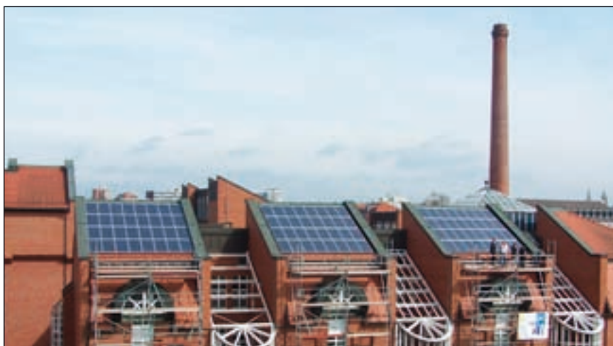
Auf den Dächern der Kasseler Universitätsbibliothek sind jetzt Photovoltaik-Anlagen installiert.
