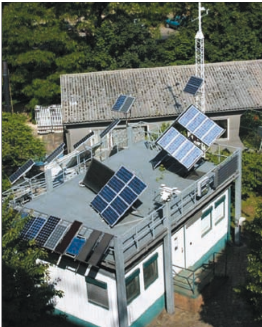
Bild 1: Blick auf das Applikationslabor Villa Sonnenschein
