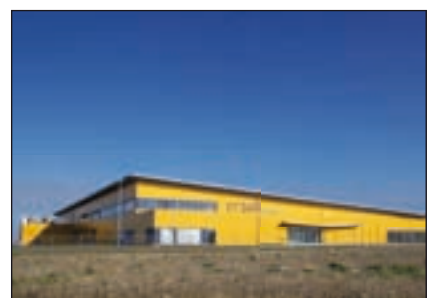
ersol-Dünnschichtfabrik (a-Si), Erfurt
