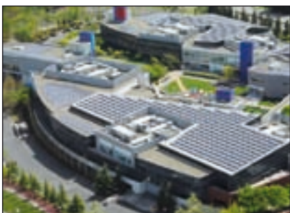
Das Firmengelände von Google wird seit Anfang 2007 von einer 1,6 MWp Solarstromanlage geizert.
