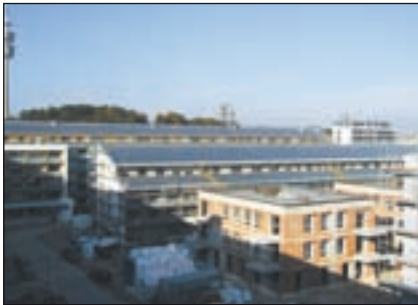
Im Münchner Stadtquartier „Am Ackermannbogen“ liefert eine der größten Solaranlagen Deutschlands umweltfreundliche Wärme.
