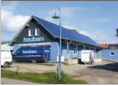
Bild 10: Dachanlage mit CdTe-Modulen
