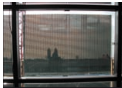
Bild 2: Semitransparente ASI-Module am Neubau der Fachhochschule München
