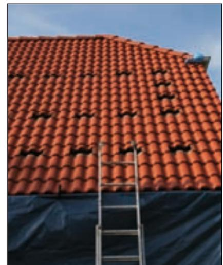
Frisch beschichtetes Dach mit Aussparungen für Dachhaken einer Photovoltaikanlage
