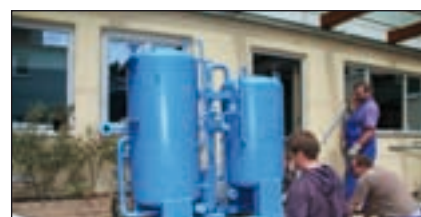
Abb. 5: Die Absorptionskälteanlage wird angeliefert
