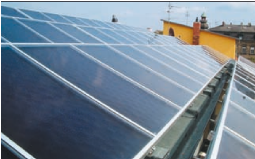
Fürth: 100 Quadratmeter Kollektoren kühlen und beheizen 1000 Quadratmeter Bürofläche
