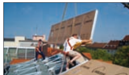
Abb. 4: Montage der Flachkollektoren
