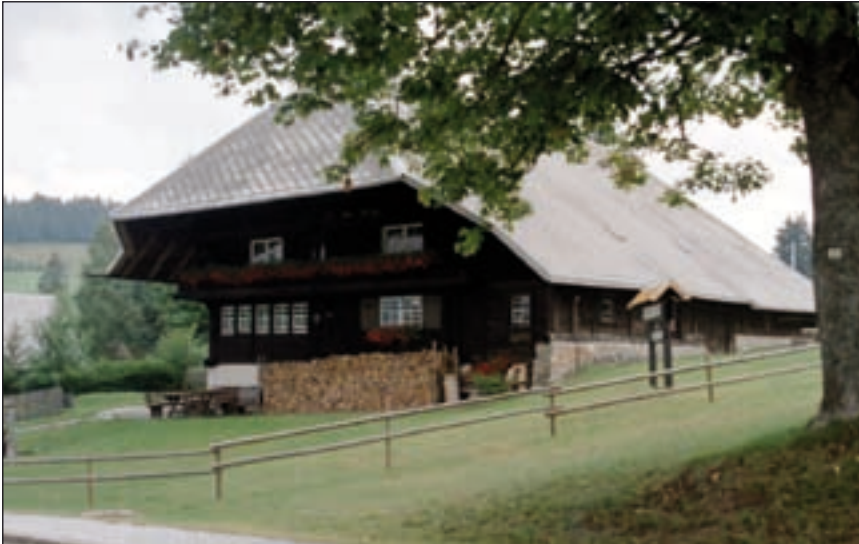
Historisches Beispiel für räumlich, konstruktiv und energetisch konsistentes Bauen: historisches Hochschwarzwaldhaus (Bernau). Das charakteristische weit überhängende Dach als Wind-, Regen und Schneeschutz – energetisch allerdings weit unter heutigen Standards.
