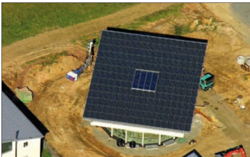
Bild 1: Ansicht des Daches von oben
