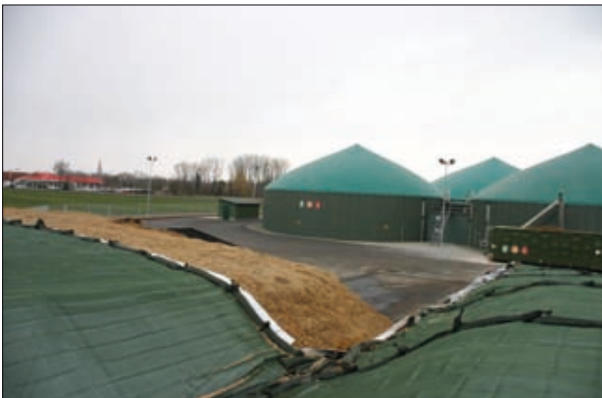
Die Biogasanlage in Bad Königshofen
