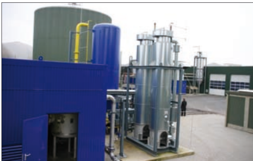
„Gasaufbereitung Werlte“: Im niedersächsischen Werlte bereitet die EWE AG Biogas auf Erdgasqualität auf und speist es ins Gasnetz ein. Die Branche erwartet für 2008 weitere Einspeiseprojekte.
