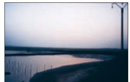
Strom per Überlandleitungen gibt es nur entlang der Hauptstraßen und damit nur für sehr wenige Dörfer. Ein Anschluss „durch den Busch“ ist zu teuer.
