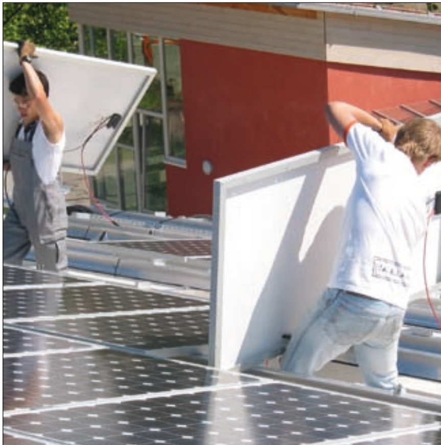
Bau einer Solarstromanlage
