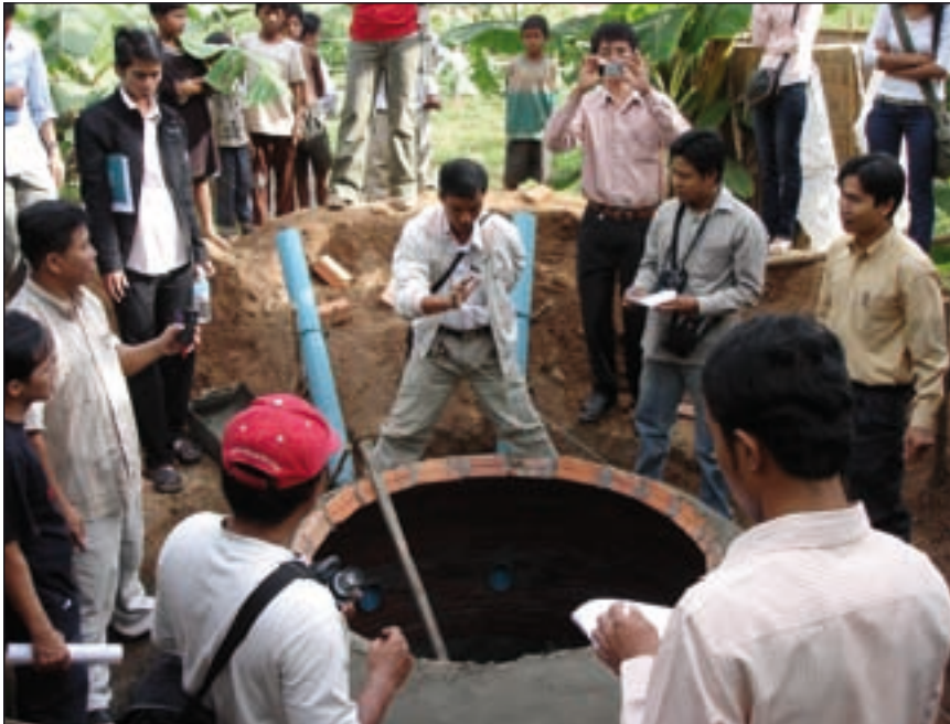
Bild 1: Kleinbiogasanlage im Bau, Kambodscha
