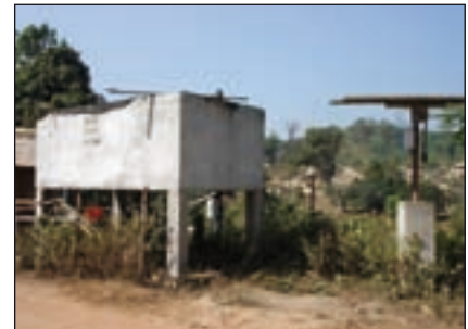
Bild 7: Wasserbehälter mit PV betriebener Distributionspumpe
