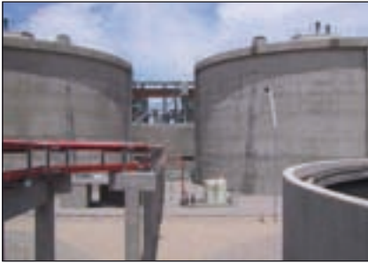
Bild 5: Klärschlammvergärung in El Trebal, Aguas Andinas
