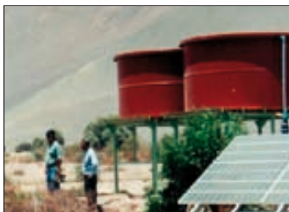
Bild 4: Solar betriebene Pumpsysteme
