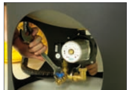
Bild 6: Bei Solarpur und Secusol (Bild) ist die Solarkreispumpe bereits vormontiert.
