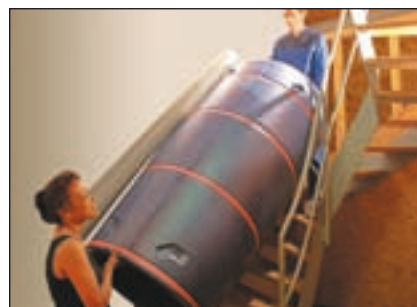
Bild 5: Der Speicher mit 490 Liter Speicherkapazität wiegt ohne Isolierung und Pumpengruppe gerade mal 42 kg (mit allem 71 kg).
