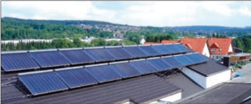
Bild 1: Dachansicht der GSTA auf dem Galvanikbetrieb der Fa. Schiffer
