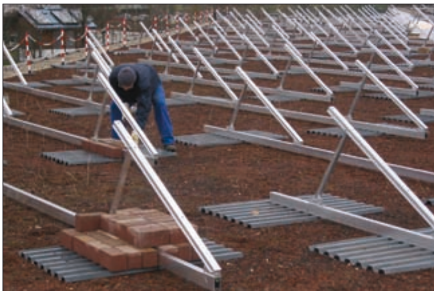
Bild 1: Montage einer Beteiligungs-Solarstromanlage auf einem Flachdach
