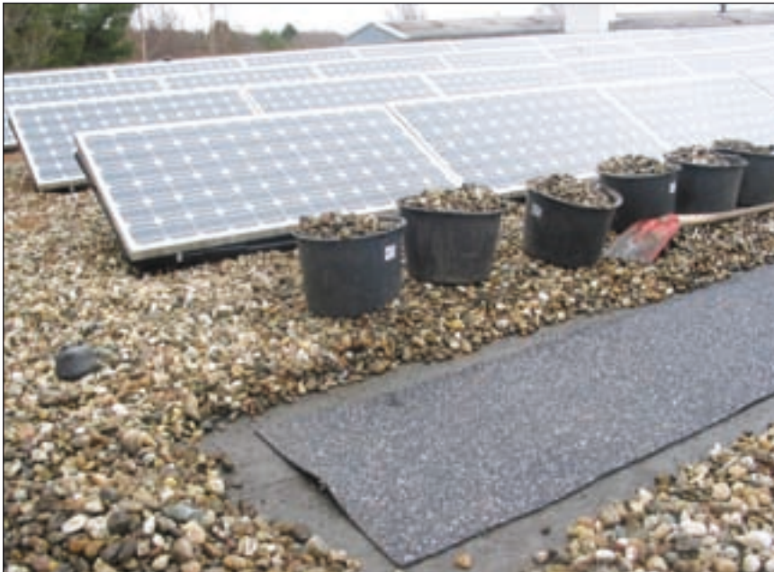
Bild 2: Fotos dokumentieren den Anlagenbau
