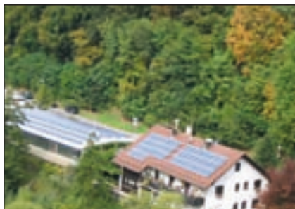
Bild 1: PV-Anlage eines kleinen Gewerbebetriebes
