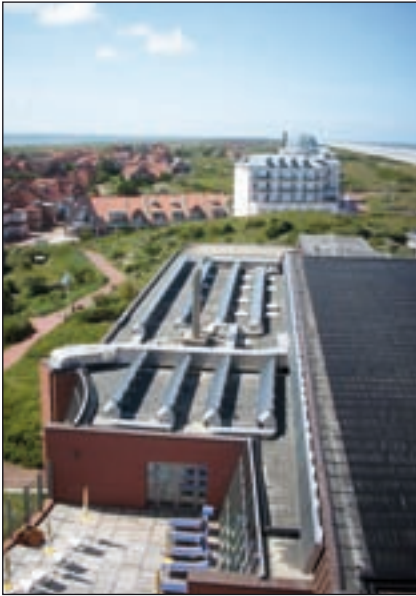
Bild 1: Hallenbad Juist – Absorber-Luftkollektor-Wärmepumpen-Kombination
