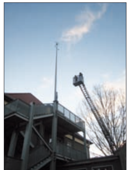
Bild 2: Installation der Sensoren und Datenlogger mit Hilfe der Feuerwehr
