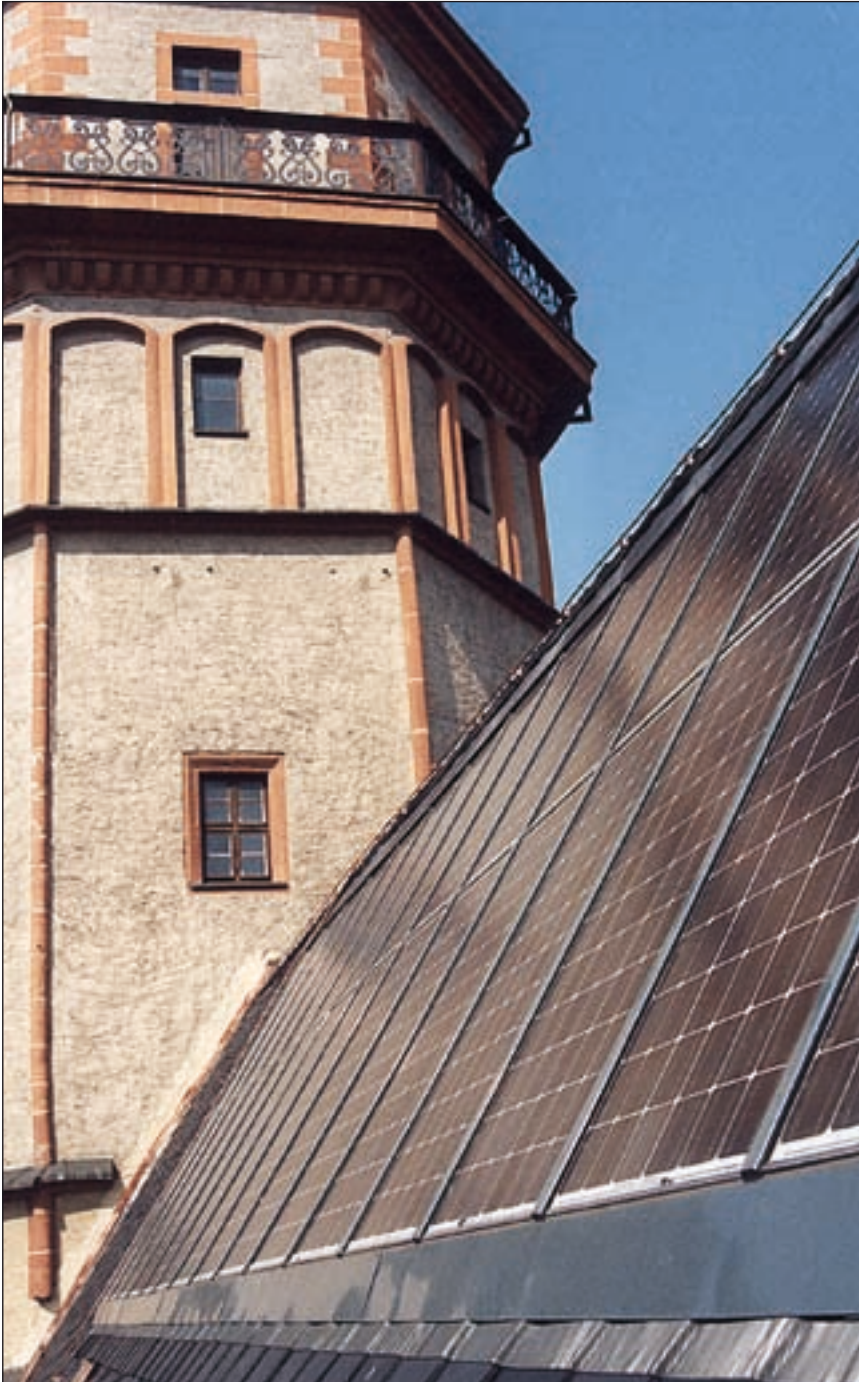
Bild 1: PV-Anlage auf dem Dach der Nikolaikirche in Leipzig
