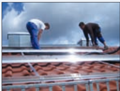
Aufdachmontage (Rudolphstraße, Nürnberg)
