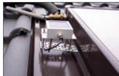
Bild 4: Bei Einstrahlungssensoren ist eine unverschattete Anbringung wichtig
