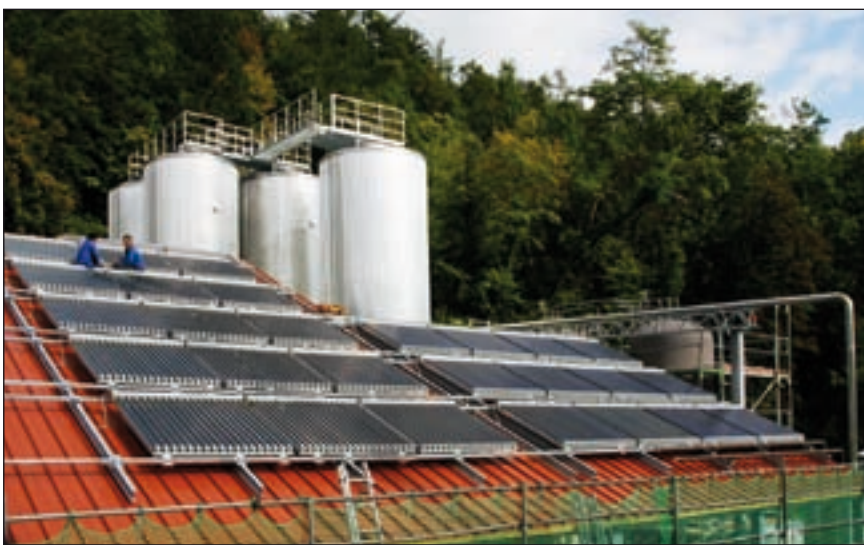
Bild 1: Montage der Kollektoren auf dem Brauereigebäude
