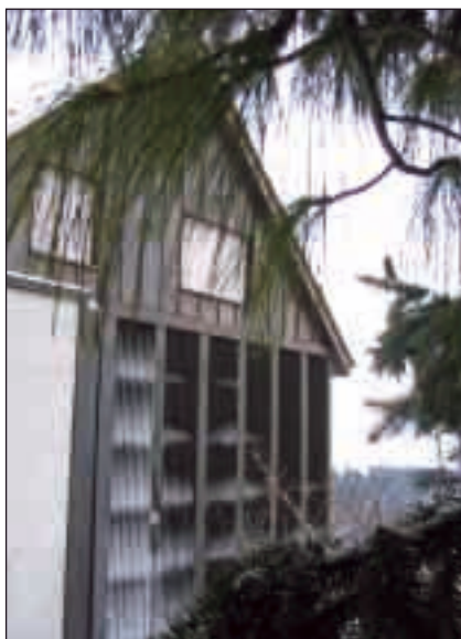
Bild 4: Thermisch aktivierte Metall-Fassade (Beck)
