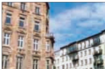
Bild 9: Bei Altbauten sind Dämmmaßnahmen aufgrund der charakteristischen Fassadengestaltung oft schwierig.
