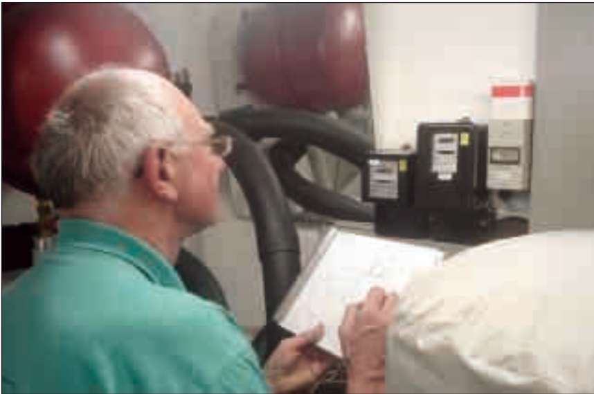
Bild 1: Ein Teilnehmer des Feldtests beim monatlichen Ablesen der Wärme- und Elektroähler seiner Grundwasser-Wärmepumpe
