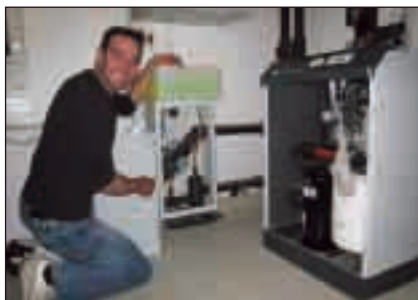
Bild 2: Da kommt Freude auf: Ein Handwerker bei der Überprüfung der Zähler-einrichtungen bei der besten Wärmepumpe im Feldtest, einer Erdsonden-Wärmepumpe.
