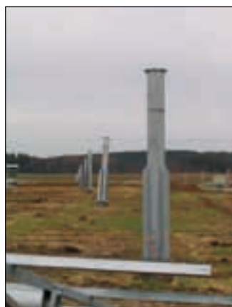
Bild 8: Beispiel für einen massiven Schadensfall an einer PV-Freiflächen-Pfahlgründung im wassergesättigten, bindigen Frühjahrsboden nach Durchzug eines Orkanes [nachführbare Anlage, Panels und Montagesystem nach dem Schaden wieder demontiert; Bilder unveröffentlicht]
