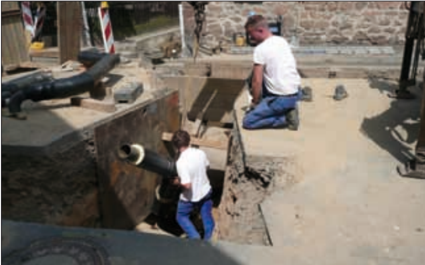
Die Nahwärmeleitungen werden verlegt
